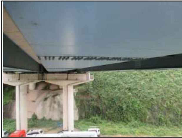
바닥판 하면, 주형 및 가로보
